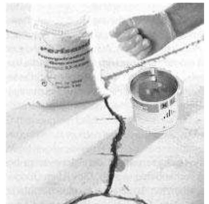
5a. Bei breiten Rissen kann das 2K EP-Bauharz mit ca. 50% Quarzsand der Körnung 0,1-0,4mm vorgefüllt werden.
