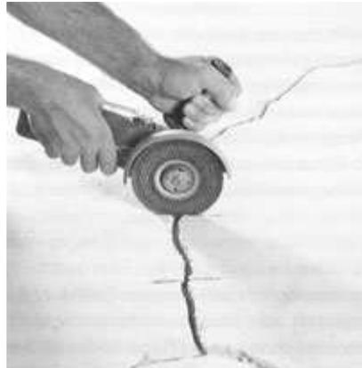
2. Quereinschnitte alle ca. 20cm mit der Flexscheibe. Die Tiefe des Schnittes sollte ca. 50% der Estrichstärke sein. Die Länge min. 7 cm.
