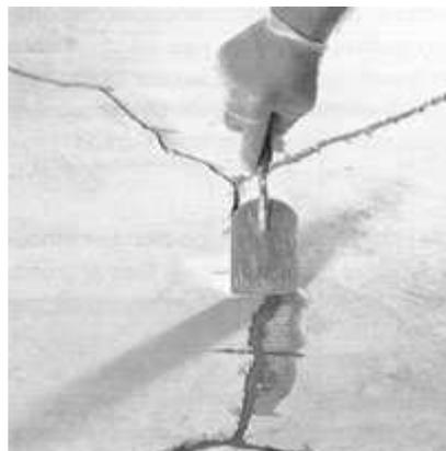
7. Nach ca. 30 Min. werden die Risse mit dem Bauharz nachgegossen und mit einer Spachtel geglättet.
