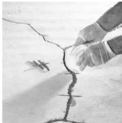
5. Jetzt wird das angemischte 2K EP-Bauharz in die Risse und Querschnitte vorgegossen,
