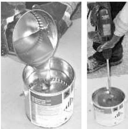
4. Das Anmischen des Megaplast 2K EP-Bauharzes (EP-Grundierung) sollte **unbedingt** maschinell mit einem Rührwandel vorgenommen werden.
