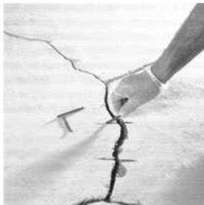
6. Einlegen der Megaplast 6x70mm Estrichklammern in die mit noch frischem 2K EP-Bauharz vergossenen Querschnitte.
