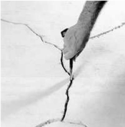
1. Erweiterung der Risse von Hand oder/und mit der Flexscheibe mit Staubabsaugung.
