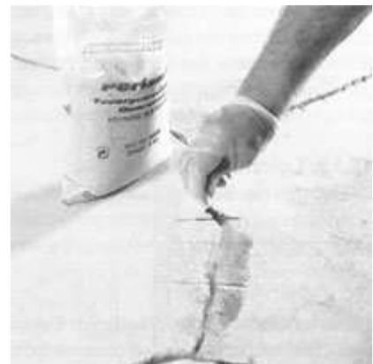
8. Die noch frische Oberfläche wird mit Quarzsand satt abgestreut. Sollte das Bauharz in den Rissen nachsacken, muss ausreichend nachgegossen werden.
