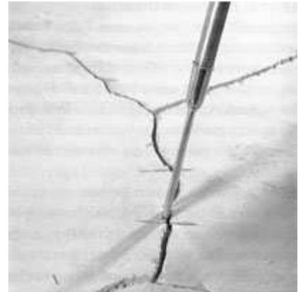
3. Das Aussaugen der Schnittstellen und Risse sollte mit einer Saugdüse vorgenommen werden, so dass diese staubfrei sind.
